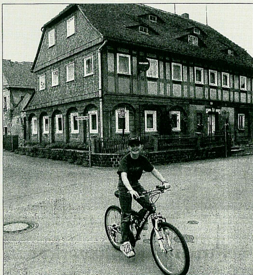
In Seiffhennersdorf an der Conradstraße soll das Grundstück der ehemaligen Fischfabrik saniert werden. Ein benachbartes Umgebendehaus, an dem gleichfalls der Zahn der Zeit nagt, soll in die Sanierungspläne einbezogen werden. Deutsche, polnische und tschechische Studenten wollen eigene Entwürfe dazu liefern. Foto: SZJens Böhmke
